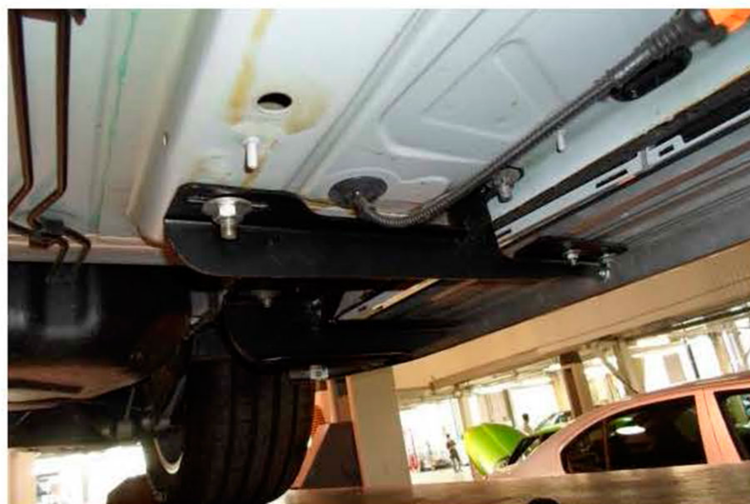
Рис.3 Установка переднего кронштейна
