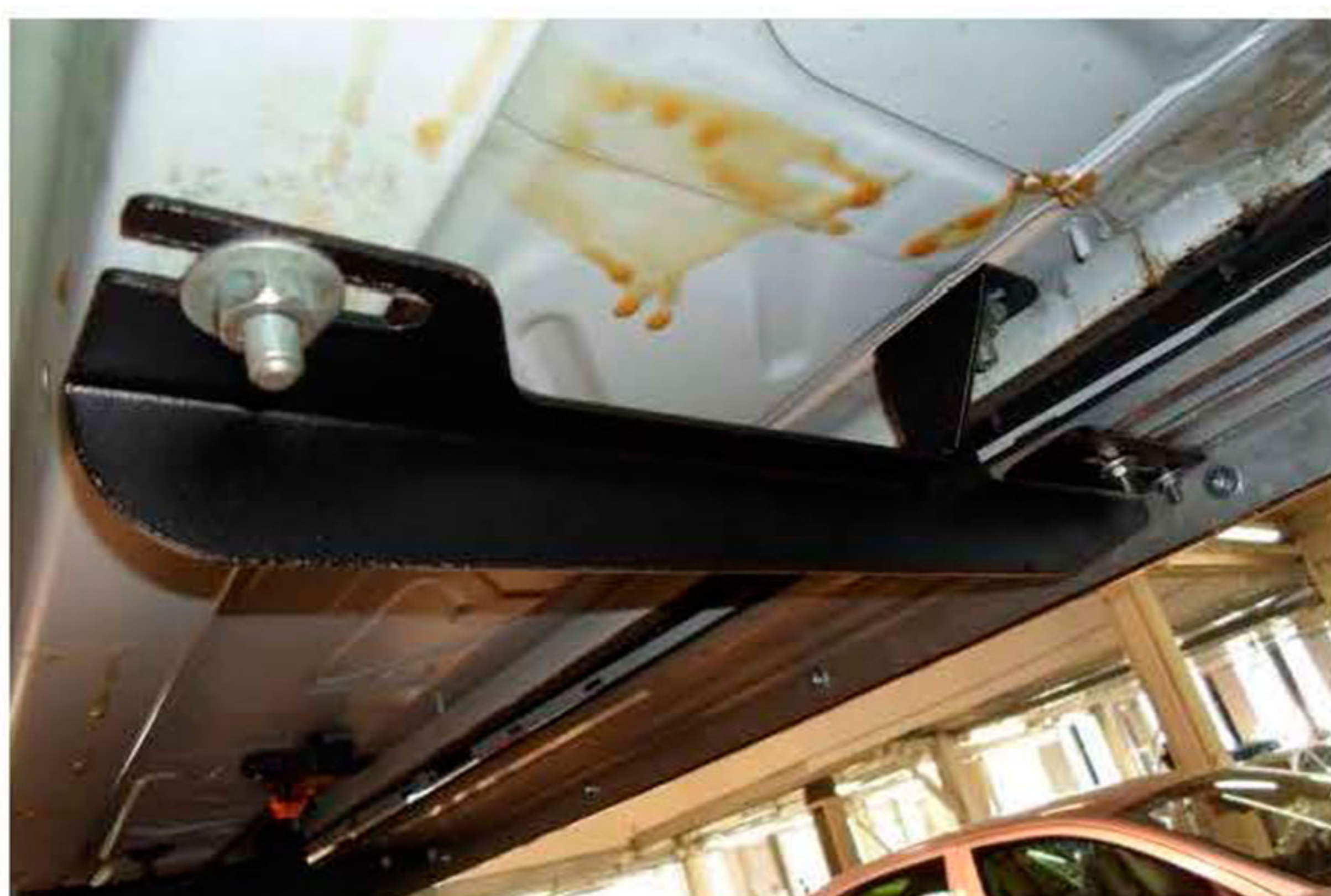
Рис.2 Установка переднего кронштейна
