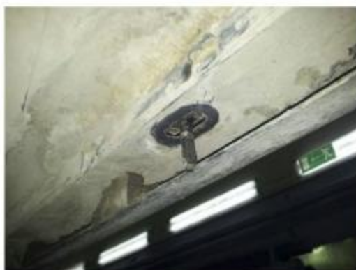
Рис.2 Установка шпильки закладной M10
